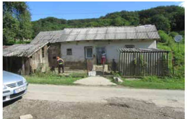
Familie R. , 5 Kinder, rundum renoviertes Haus :Dach, Fenster, Putz, neues Kinderzimmer
