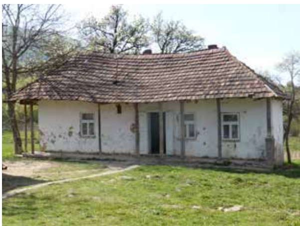
Familie K, 6 Kinder, neues Dach, neue Fenster
